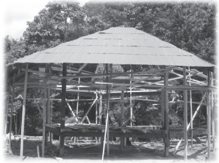
ภาพที่ 2 ก่อสร้างอาคารศูนย์เรียนรู้
